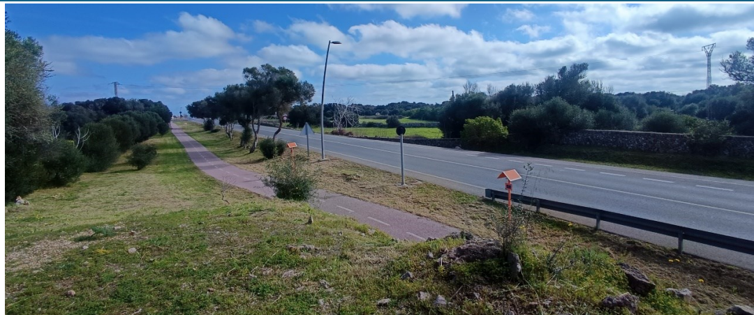
Figura 64. Carretera Me-12 Maó-Sant Climent, amb carril bici i il·luminació pública amb fanals. Es perceben dues torres i el cablejat de la línia de MT que subministra electricitat a l'aeroport.
