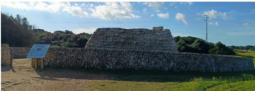
Figura 8. Torre i cablejat de mitja tensió, a 60 m. al sud de la naveta.
