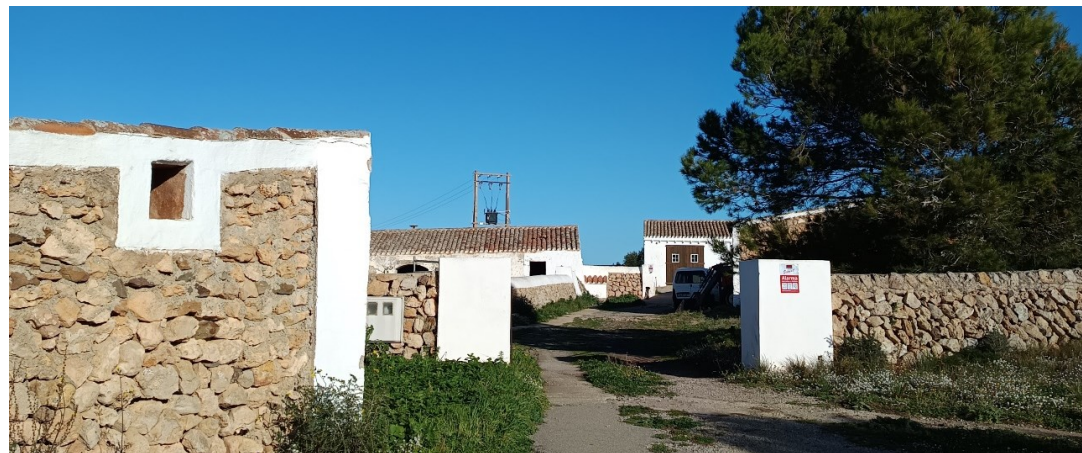
Figura 75. Vista de les cases del lloc de Sa Torreta de Tramuntana. El subministrament elèctric del lloc arriba a través d'una línia de MT, que en aquest punt és transformada en BT. En la fotografia es pot veure la torre amb el transformador de BT. És l'única estructura visible en aquest entorn, però des del recorregut de visita del poblat és totalment invisible, excepte si hom puja al talaiot.
