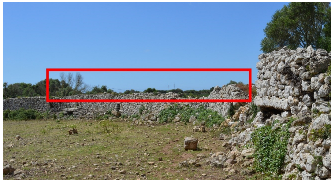
Figura 15. Dins el rectangle vermell, la línia de BT, lleugerament visible a l'horitzó des de l'espai emmarcat per la muralla del poblat.
