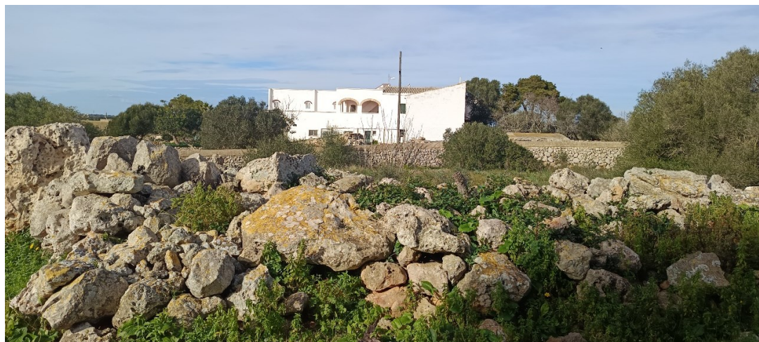
Figura 21. Vista de les cases del lloc de Son Catlar des del recorregut exterior de la muralla. Davant les cases s'observa el pal de fusta sense cablejat.
