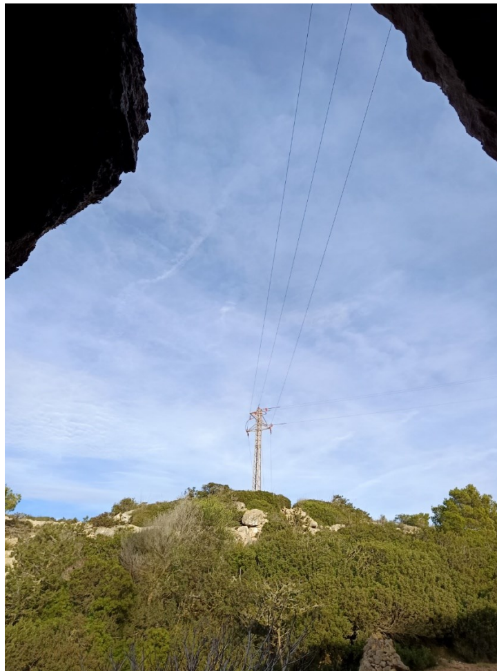
Figura 78. Una altra de les torres de MT que afecten visualment la necròpolis. En aquest cas, la fotografia està presa des de l'entrada d'un dels hipogeus. La torre trenca la visual de l'horitzó.
