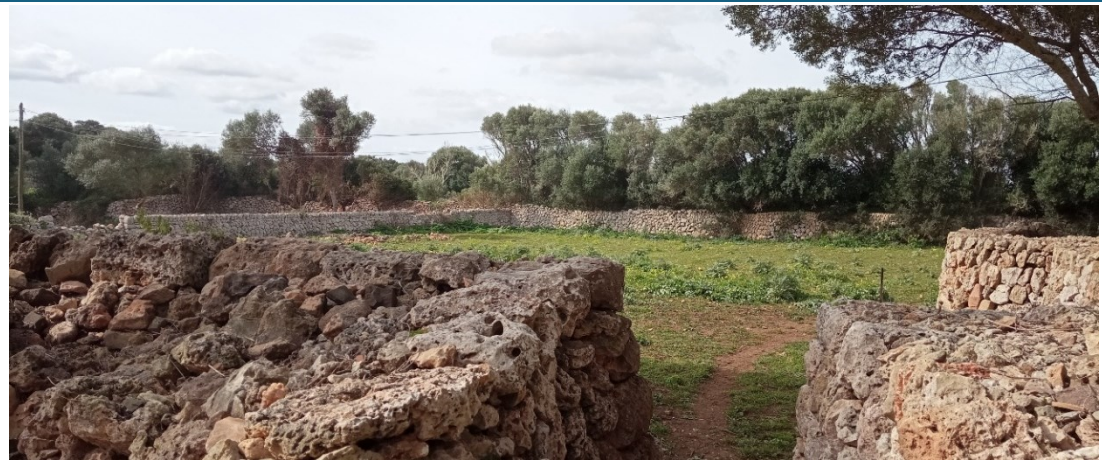
Figura 81. En primer pla, la zona on es duu a terme la intervenció arqueològica. La línia de BT passa per la tanca del costat, amb el cablejat a poca altura, dificultant el pas del camió grua.
